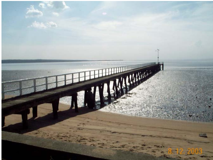
Lang Lang Jetty
